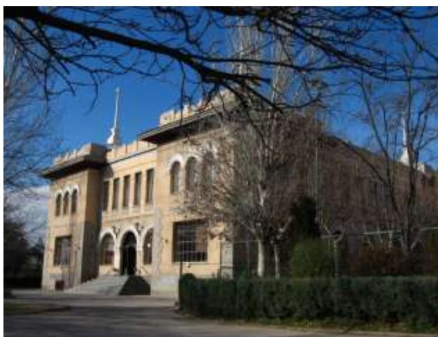
Edificio E del Instituto Isabel la Católica, antigua Sección Retiro del Instituto-Escuela
